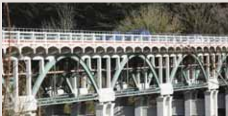
© Viaduc de Toupin
